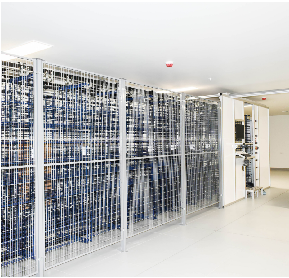
CARRUSEL HORIZONTAL BODEGA DE FÁRMACOS
