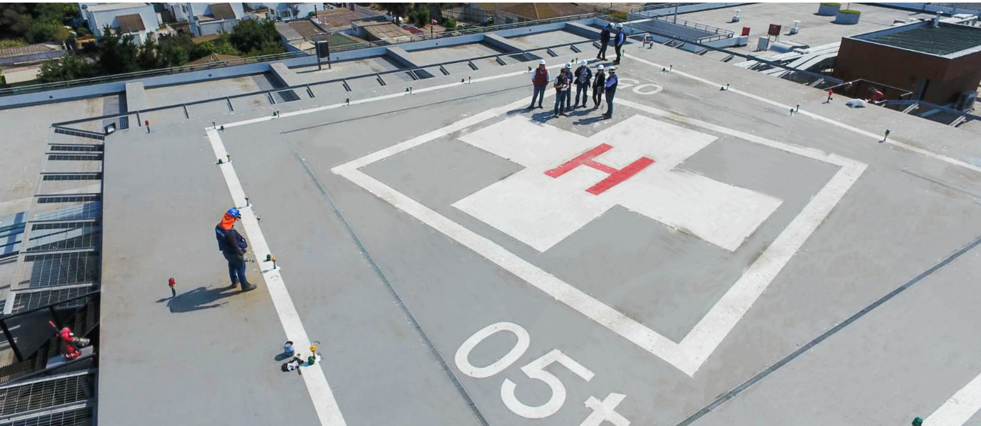
HELIPUERTO. Uno de los últimos recintos en ser revisados por la Comisión fue la cubierta del edificio, incluido el helipuerto del NHCV
