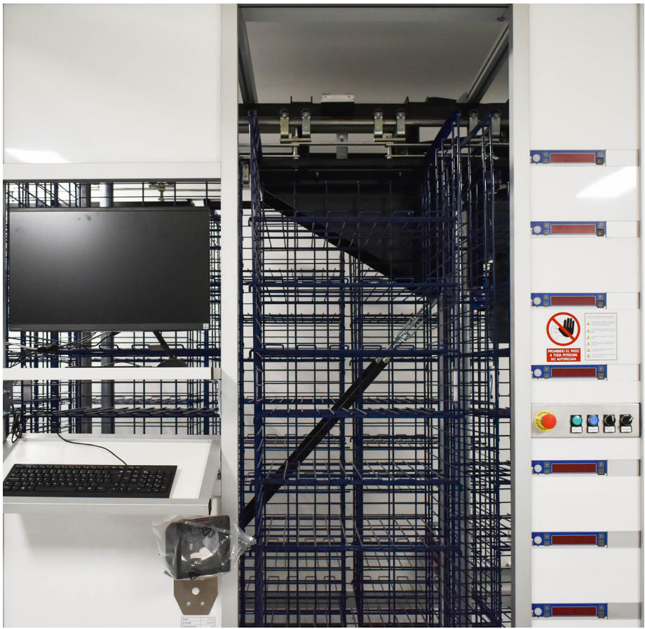
CARRUSEL HORIZONTAL BODEGA DE FÁRMACOS
