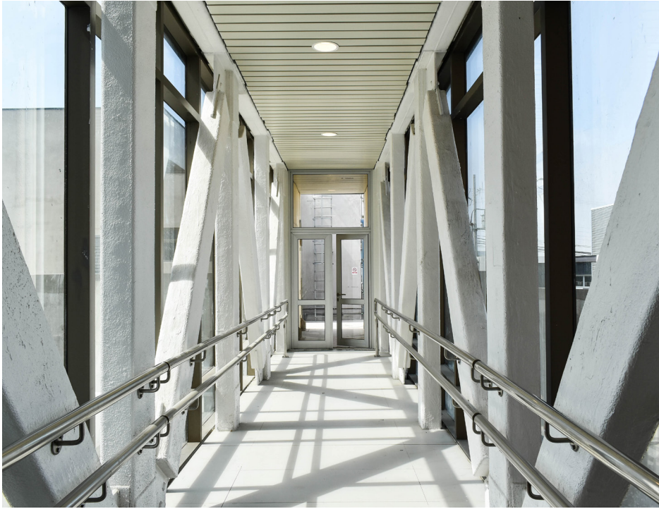
Puente conexión a REAS
