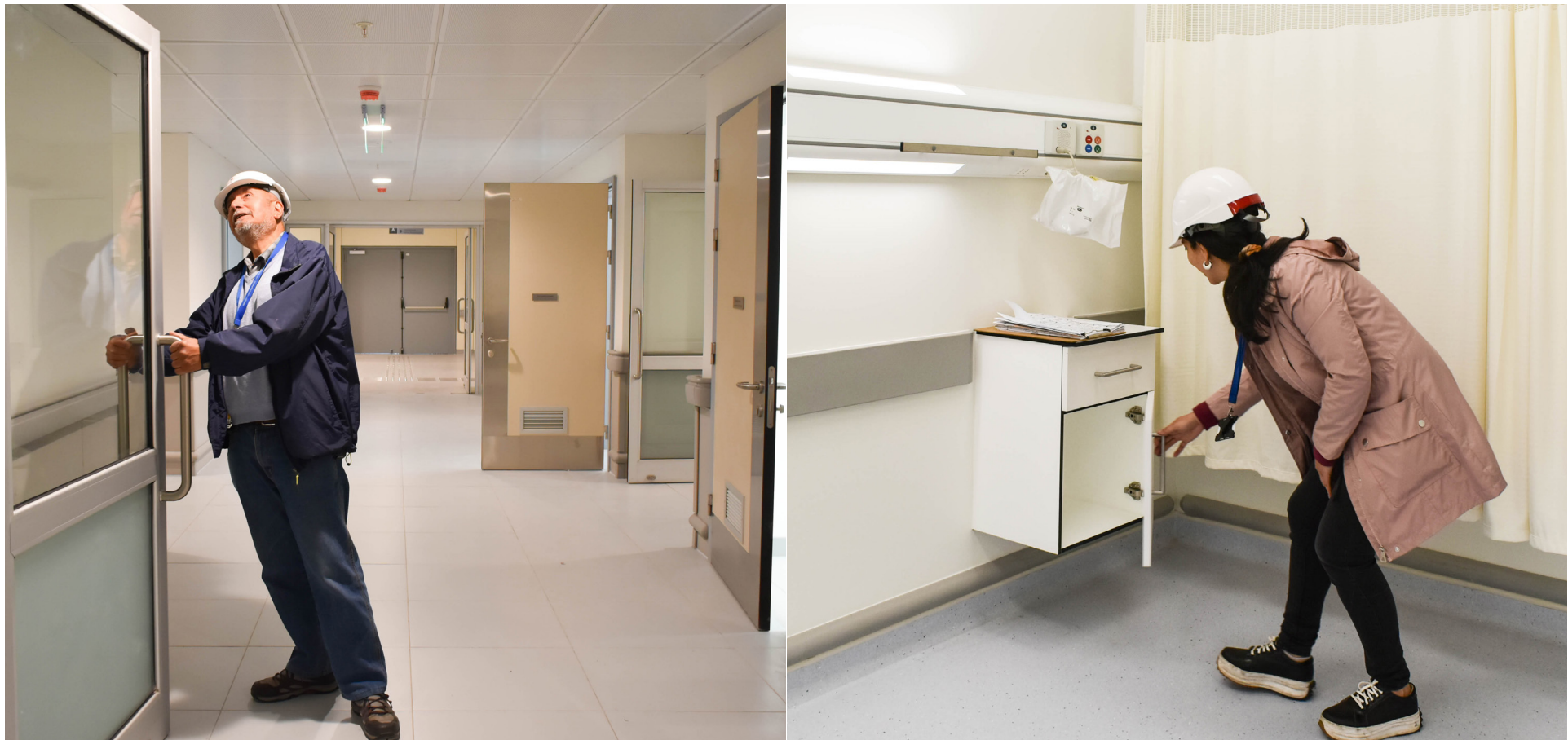
REVISIÓN. El correcto funcionamiento de puertas, mobiliario, red húmeda y grifería son solo algunas de las áreas a las que se aboca la Comisión de Recepción.
